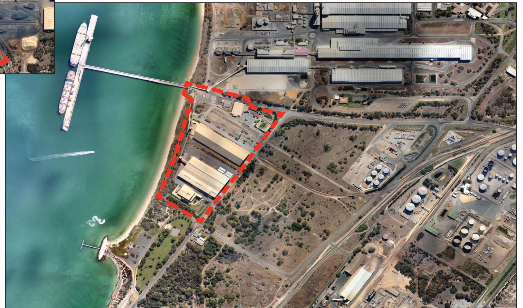
Extent of Kwinana Bulk Jetty
