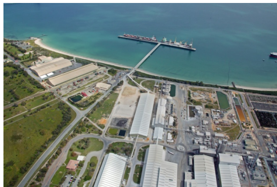
Kwinana Bulk Jetty
