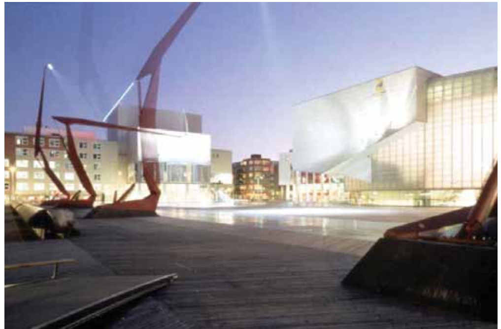
Schouwburgplein Square, Rotterdam.
